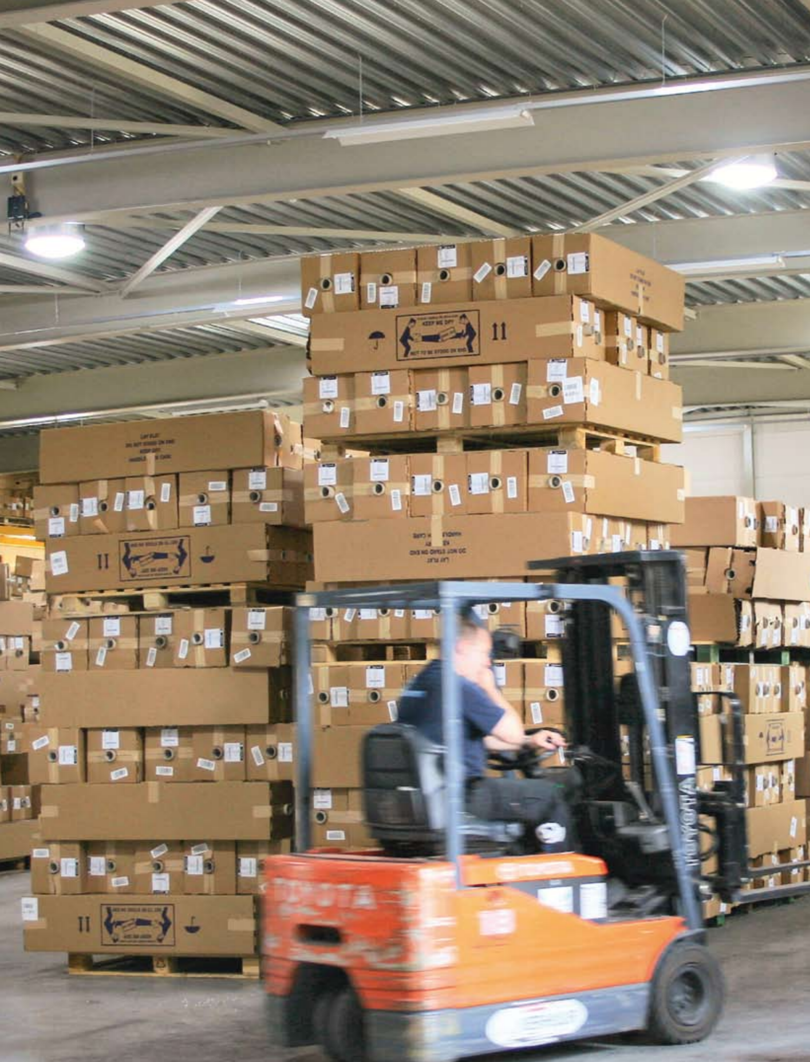
Energiebesparing én prettig werken, dat is bereikt met 21 Solatube-systemen. Project in Culemborg (NL).
