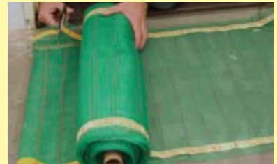
Uitrollen van het verwarmingselement
