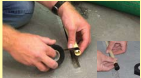
Duw de voelderdraad vervolgens aan het einde terug en tape of dop deze zorgvuldig af.
