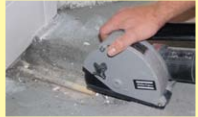
Sleuf maken vloervoeler
