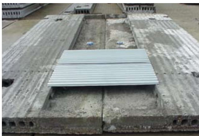
Leggen van de LEWIS® Zwaluwstaartplaten® (foto boven en onder).
