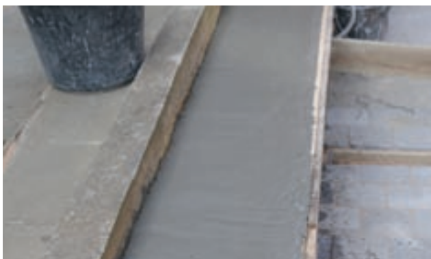
Gelijkmatig glanzend goed verdicht beton
