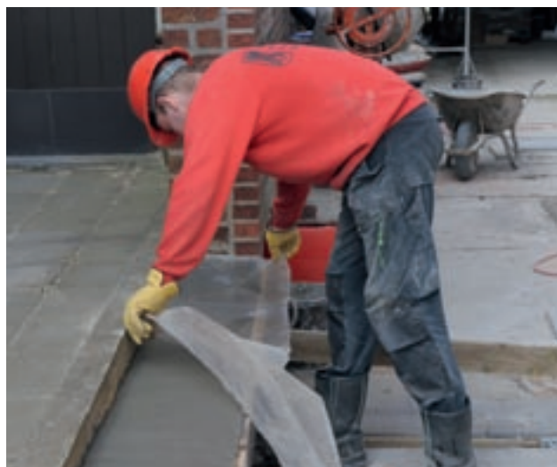
Voorkom voortijdige verdamping door het beton af te dekken
