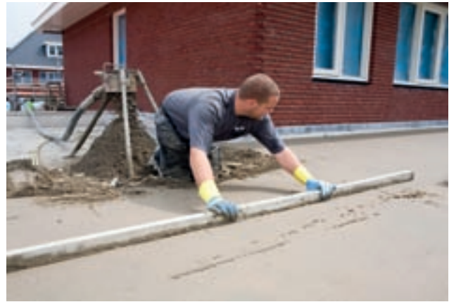
Uitvlakken met behulp van een rei
