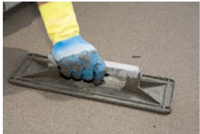
Afwerking: vlakschuren met een houten spaan
