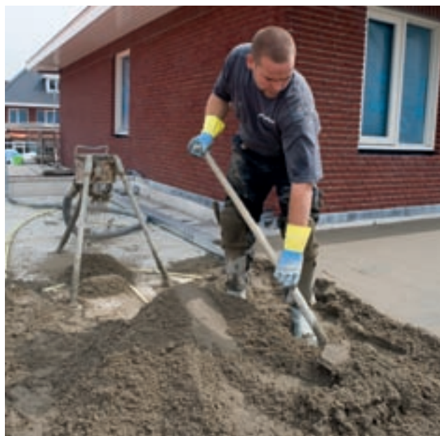
Eerst het zand en het cement droog mengen
